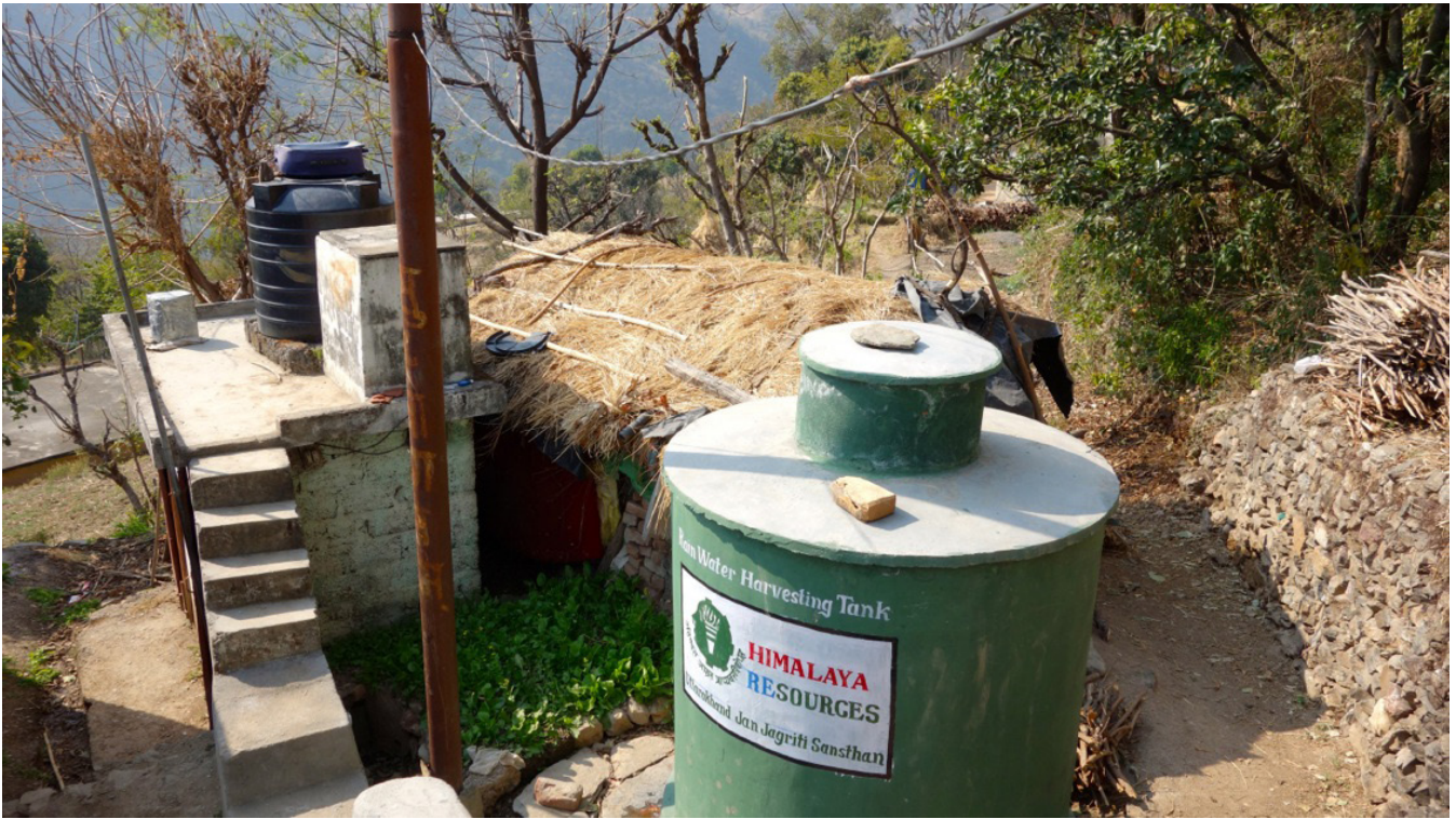
Opvangtank voor regenwater (rooftop watertank)
