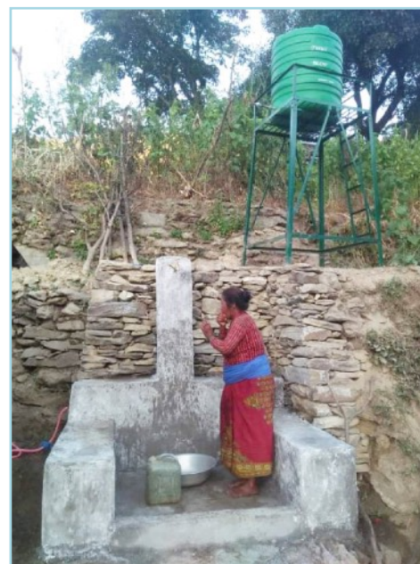
Opslagtank en watertap
