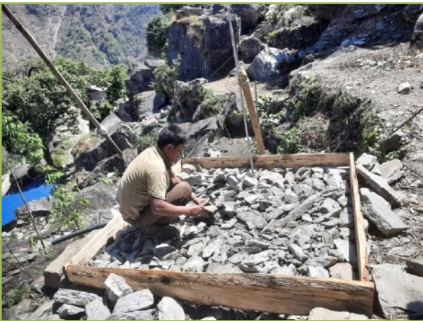
Waterkraan tijdens de bouw in Marming
